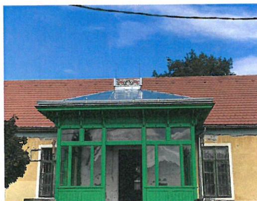
Legrégebbi épületrész (a tetőszerkezet felújítása megkezdődött)
